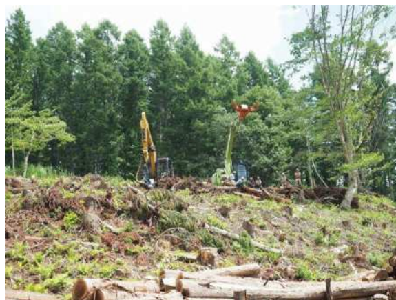
スウィングヤードによる集材作業
