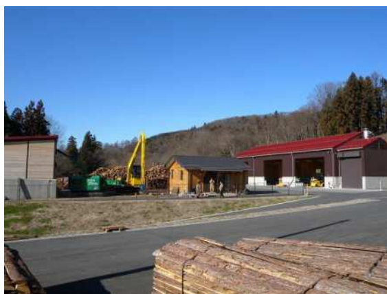
ウッドビレッジ川場（全景）
