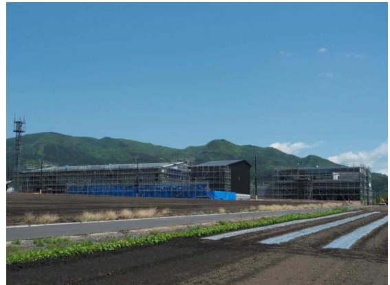
SGEC認証材の使用（建築中の川場役場庁舎）
