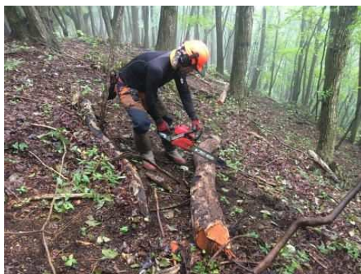
水源地域の作業状況
