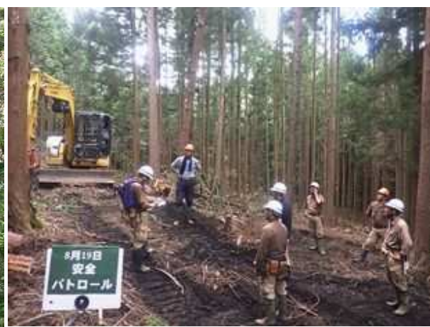
職員による現場安全パトロール
